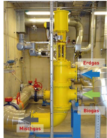
Abb. 8: Zweidimensionales Mischventil des Typs ZDM
