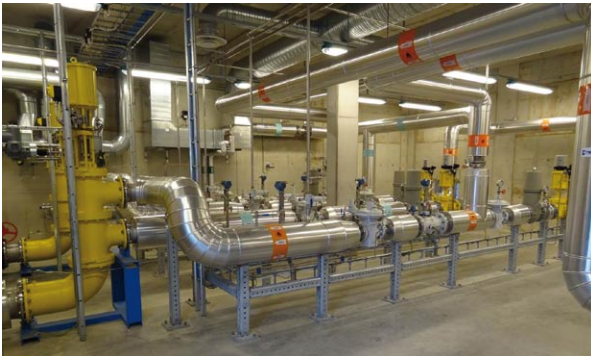
Abb. 7: Gas-Mischstation mit zweidimensionalem Mischventil
